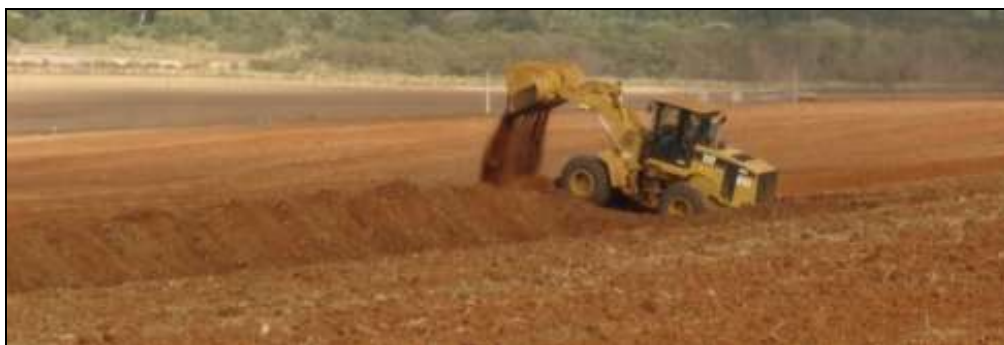
Figura 5 - Construção de terraço.
