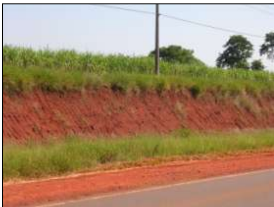
Figura 38 - Talude de estrada apresentando latossolo vermelho, também chamado de terra roxa, apresentando boa estabilidade por apresentar textura argilosa.
