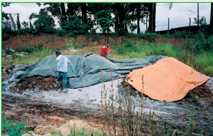
Aplicação de lona plástica sobre resíduos químicos que reagem com água
