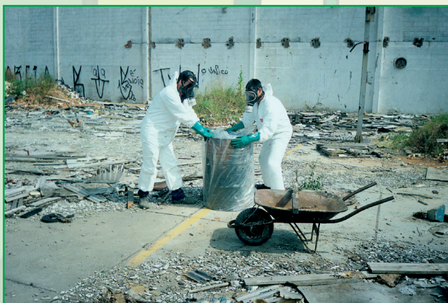
Operação de encapsulamento de tambores contendo resíduos químicos
