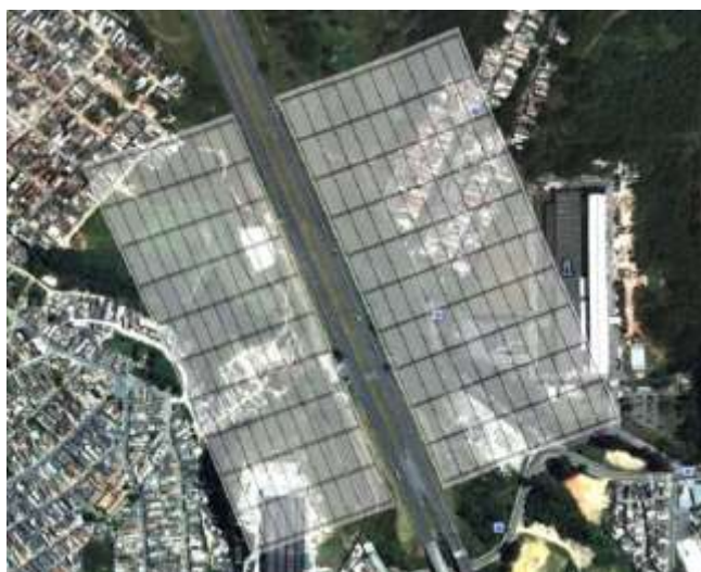
Figura 12 – Assumindo-se que seja foco de análise a pista da direita, a lateral da área de influência oposta terá largura menor que 300 metros, pois a medição deverá ser feita a partir do bordo da via em análise
