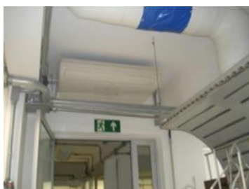
Sala de Extração Limpa (Entrada)
