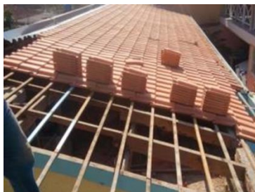
Troca telhas cobertura
