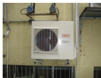
Unidade condensadora
