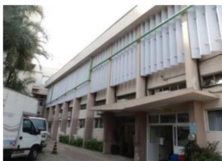
Captação das águas das chuvas por meio de calhas e condutores que após filtragem primária serão armazenadas em tanques instalados na superfície
