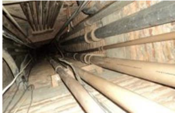
Prumadas executadas nos shaft's do prédio 1
