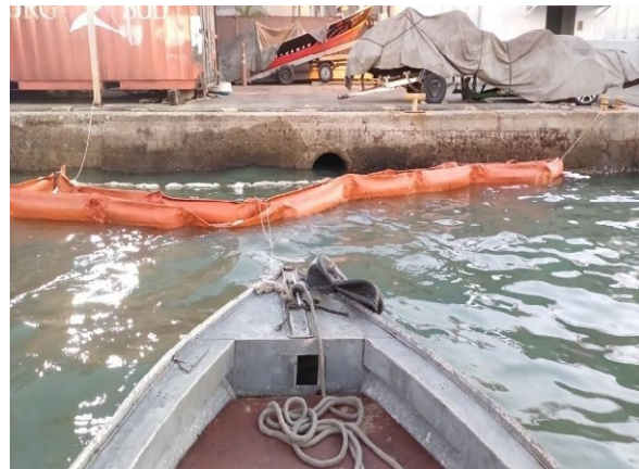
Figura 5.3 – Mancha oleosas identificada na proximidade do Terminal XXXIX (a) e contenção do resíduo oleoso lançado a partir do bueiro do sistema pluvial do município (b)
