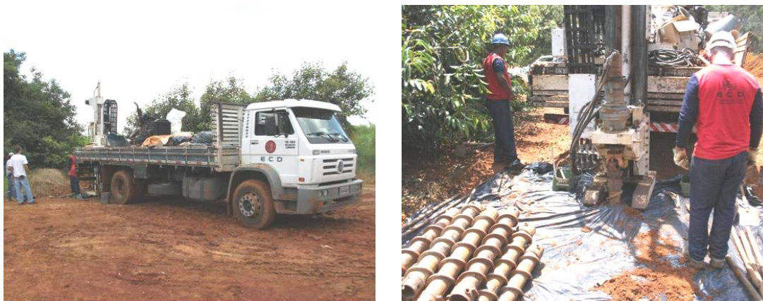
Figura 36. Equipamento utilizado nas sondagens (trado helicoidal oco)
