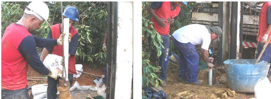
Figura 45. Colocação do pré-filtro e início do desenvolvimento (pistoneamento)
