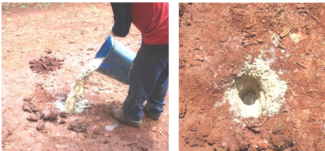
Figura 43. Procedimento de selamento dos furos de sondagem com calda de bentonita
