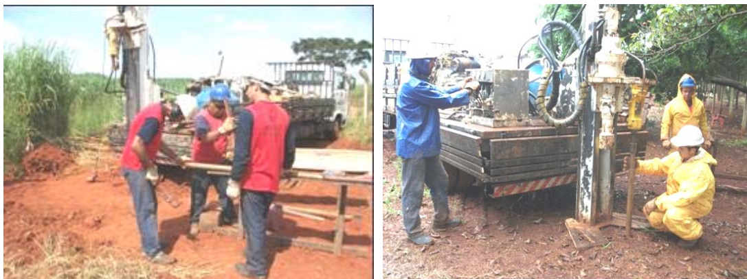
Figura 40. Preparação do amostrador e cravação por percussão.
