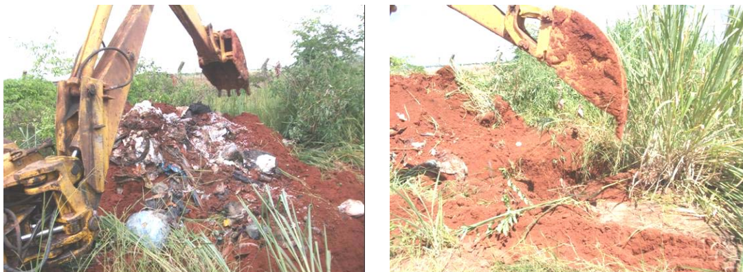
Figura 39. Procedimento de remoção dos resíduos da vala mais antiga do aterro de Jaci, visando à preparação para a perfuração.
