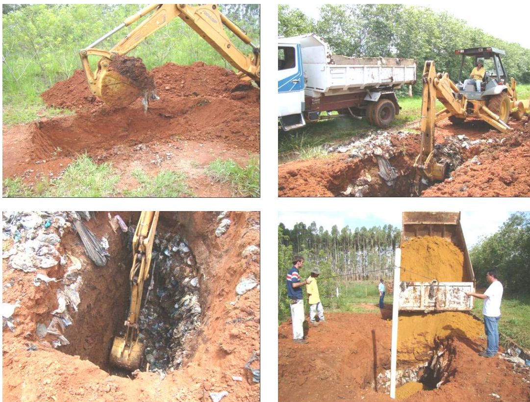
Figura 38. Procedimento de remoção dos resíduos da vala mais antiga do aterro de Angatuba, visando à preparação para a perfuração.
