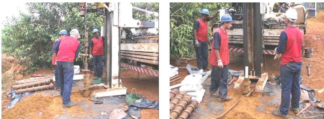
Figura 44. Retirada da haste interna do trado oco e colocação dos tubos filtro e de revestimento
