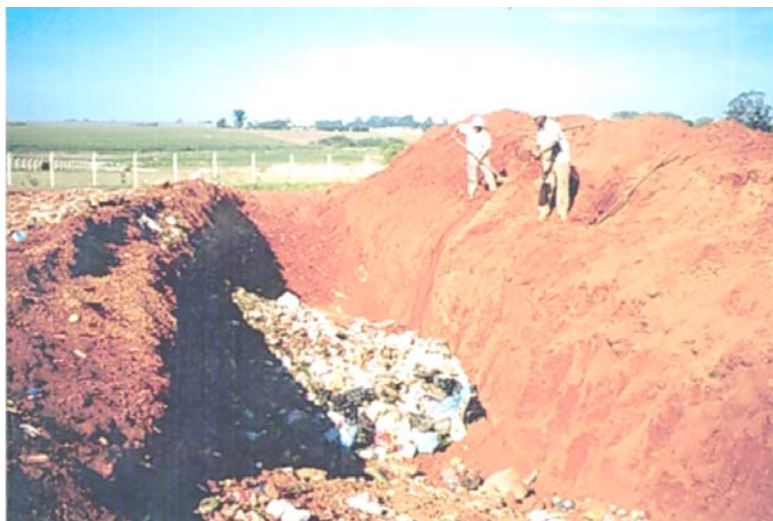
Figura 9. Detalhe da cobertura manual dos resíduos com solo, logo após seu descarregamento.
