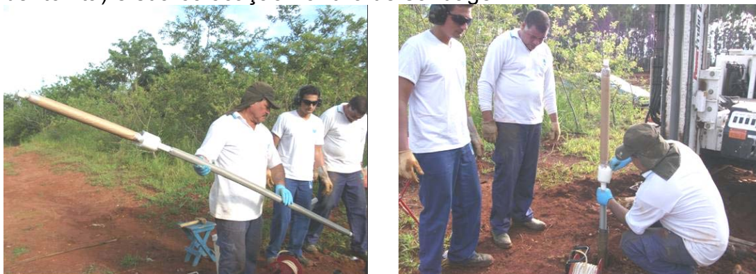
Figura 48. Detalhe do poço pré-montado (Filtro, pré-filtro e selo de bentonita) e sua colocação no furo de sondagem.
