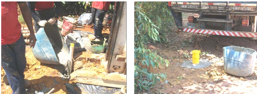
Figura 47. Preenchimento do espaço anelar com cauda de bentonita e cimento, e finalização do poço.
