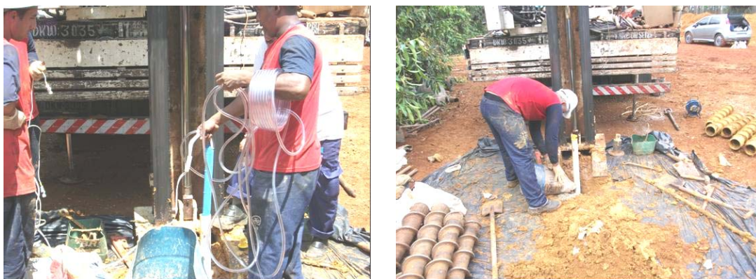
Figura 46. Continuidade do desenvolvimento (bombeamento) e colocação do selo de bentonita em pellets
