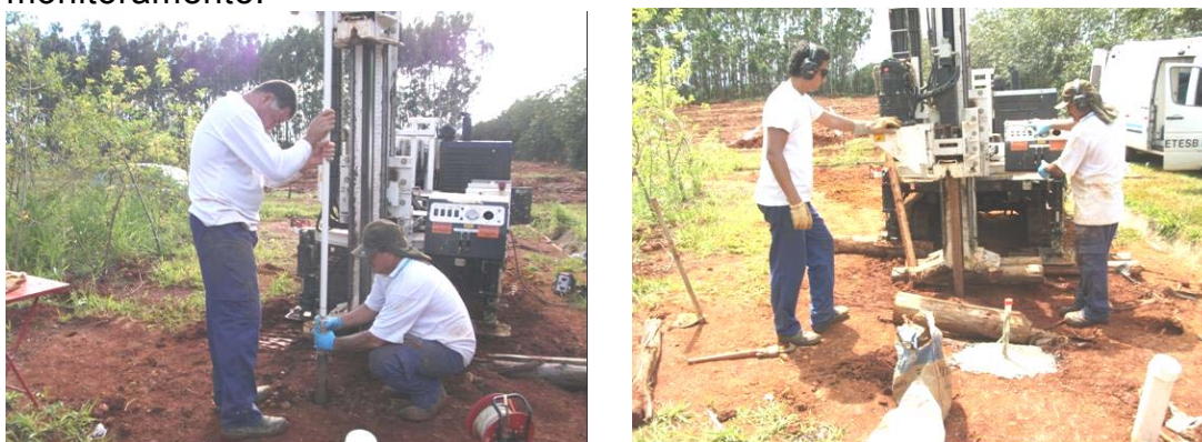
Figura 49. Colocação do tubo de revestimento e finalização do poço de monitoramento.
