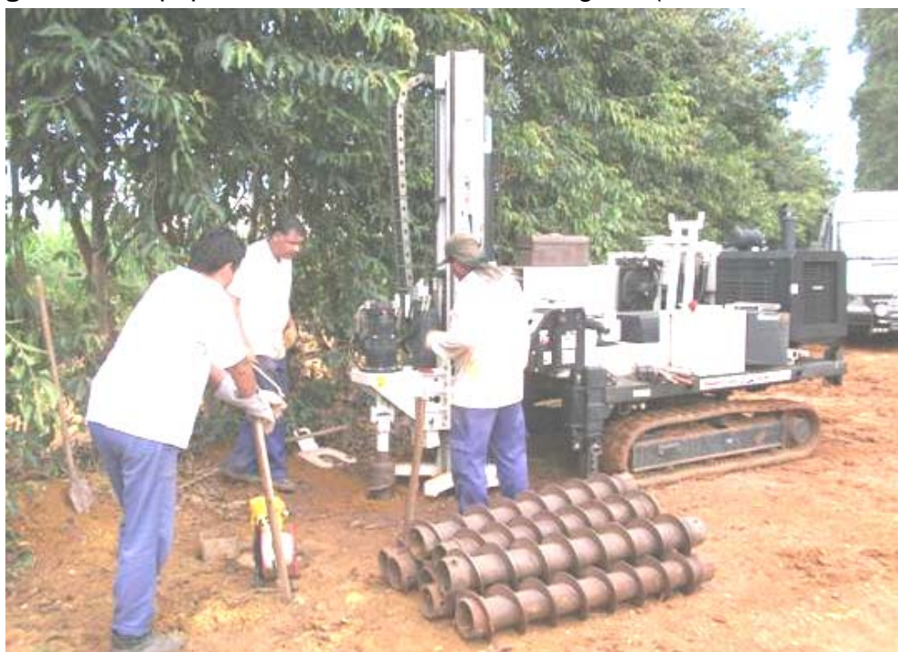
Figura 37. Equipamento utilizado nas sondagens (trado helicoidal oco)
