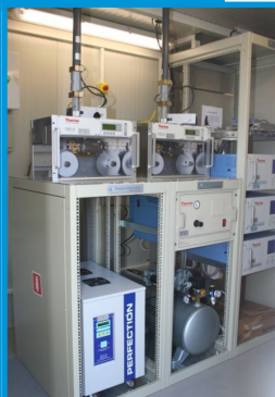
Interior da Estação
