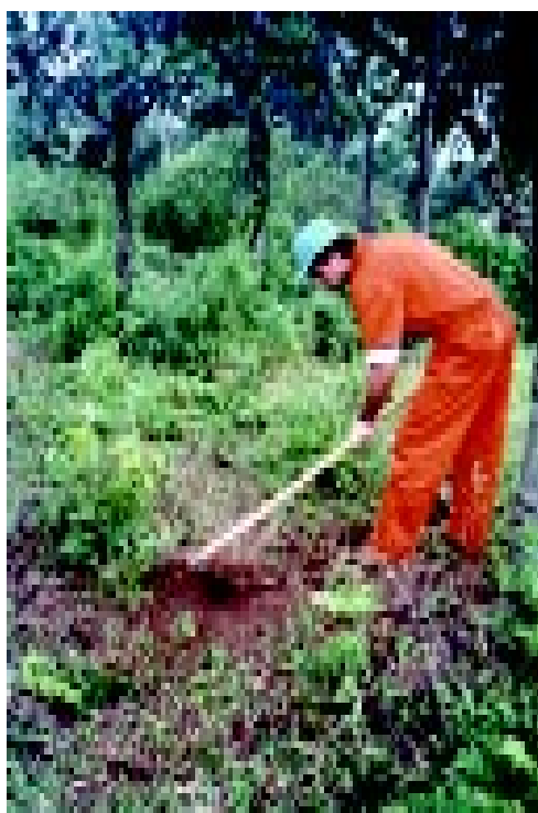
Fig. 3.3. Ilustração da remoção de vegetação e material grosseiro da superfície do local.
