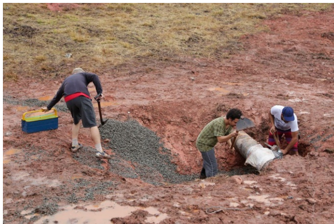
Figura 1.6-10 – Simulação de derivação clandestina em dutos
