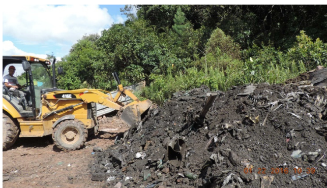
Figura 1.6-7 – Remoção de solo contaminado
