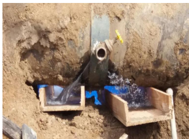
Figura 1.6-15 – Trepanação do duto
