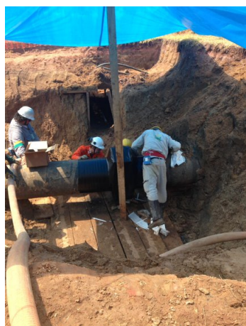
Figuras 1.6-17 a e b – Solo escavado em ocorrência de derivação clandestina de combustíveis em duto
