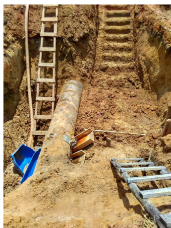
Figuras 1.6-17 a e b – Solo escavado em ocorrência de derivação clandestina de combustíveis em duto
