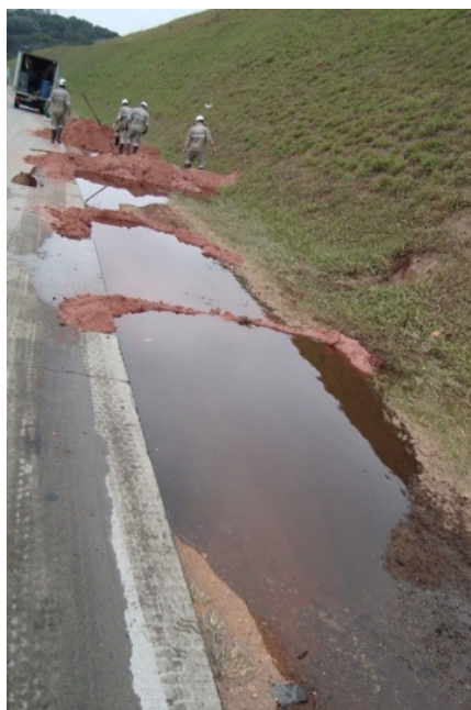
Figura 1.6-2 – Diques para a contenção de produto químico no solo
