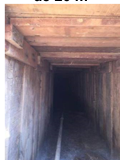
Figura 1.6-13 – Túnel escavado de 20 m
