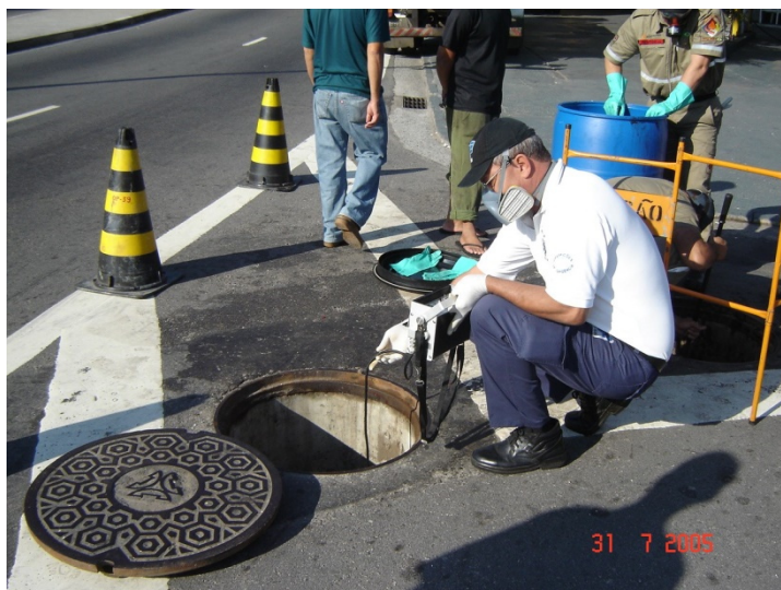
Figura 1.6-3 – Monitoramento realizado em galeria subterrânea de telefonia para verificação da presença de gases/vapores inflamáveis
