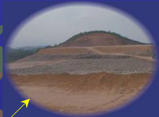
Recuperação Ambiental do antigo Vazadouro de Marambaia
