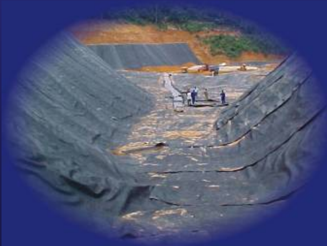
Manta de PEAD para impermeabilização
