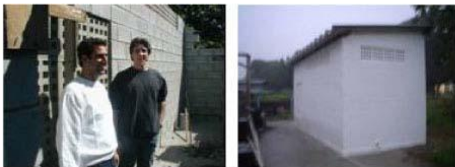
Figuras 10 e 11- Construção em Alvenaria para Abrigo dos Equipamentos
