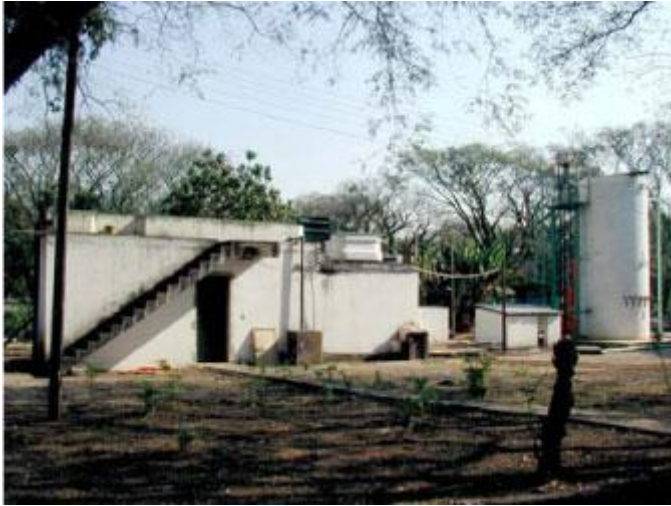
Figura 6- Sistema de Pré-Tratamento do Efluente.
