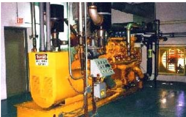
Motor Alternativo de Combustão Interna (100 kW a 3 MW)
