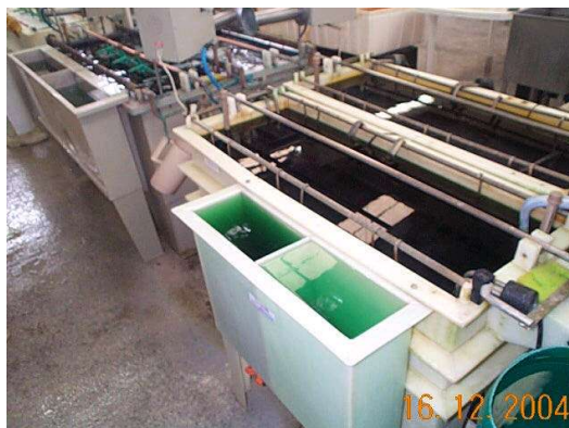
Figura 9. - Banho de níquel com tanque de drag-out
