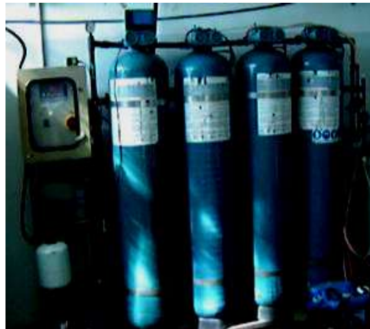
Fig.22- Equipamento de troca iônica
