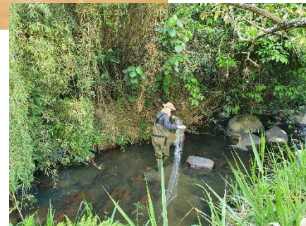
Instalação de rede de espera
