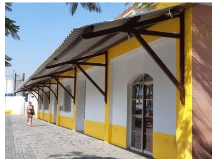
Museu de Itupeva, localizado na antiga estação de trem de Itupeva
