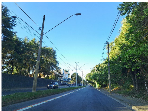
Avenida Danilo Stanzani, continuação da Avenida Shishima Hifumi.
