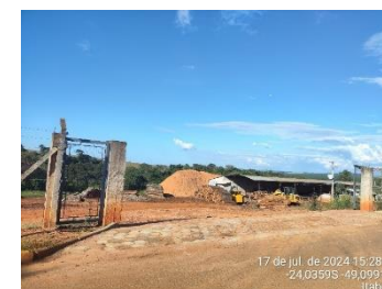
Instalações de empresas na localidade do Distrito Engenheiro Maia, Itaberá
