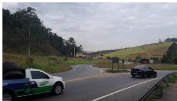
Rotatória Rod. Tancredo de Almeida Neves, Rod. Edgard Máximo Zambotto. Acesso para Campo
