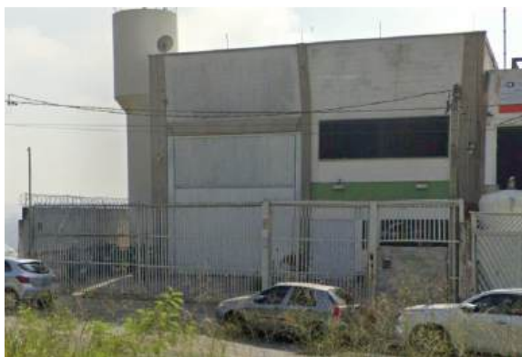
Empresa Ecoper Química. Foto tirada da Estrada Municipal do Belém. Fonte: Streetview, Googlemaps; consultado em junho de 2024.
