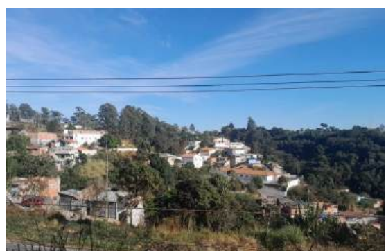
Vista parcial da Vila Leopoldis.
