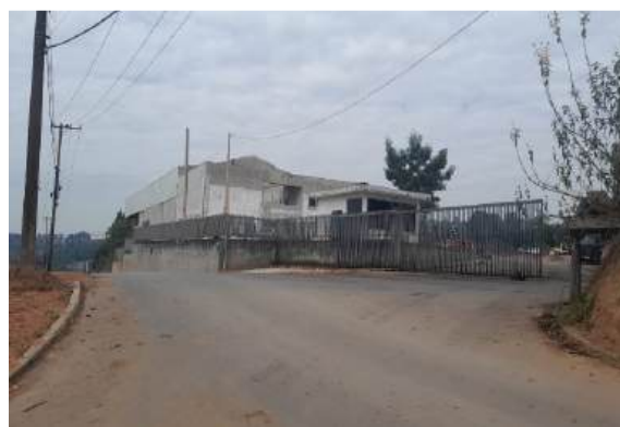
Vista Galpão, Rua de acesso a Estrada Sete Voltas.
