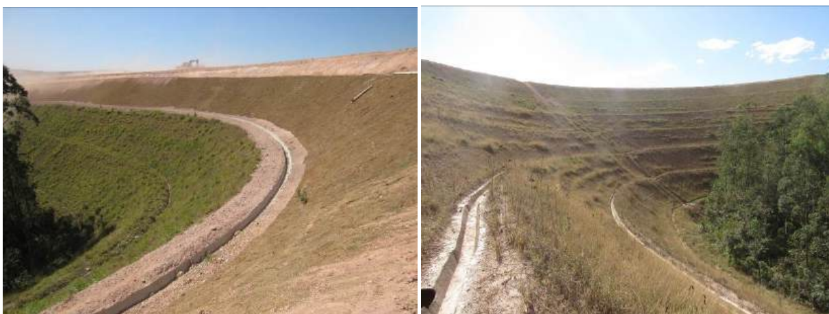
Detalhe de taludes situados a oeste e sul da ADA.
