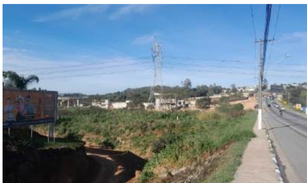
Obras estação de tratamento de esgoto a esquerda.
