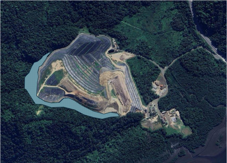
Figura 1.3 - Área diretamente afetada pela ampliação proposta Fase SA4.
