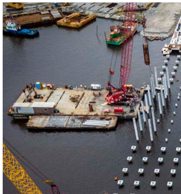
Exemplo de uso da Técnica de Balsas com Guindastes - Cravação de estacas de concreto.
