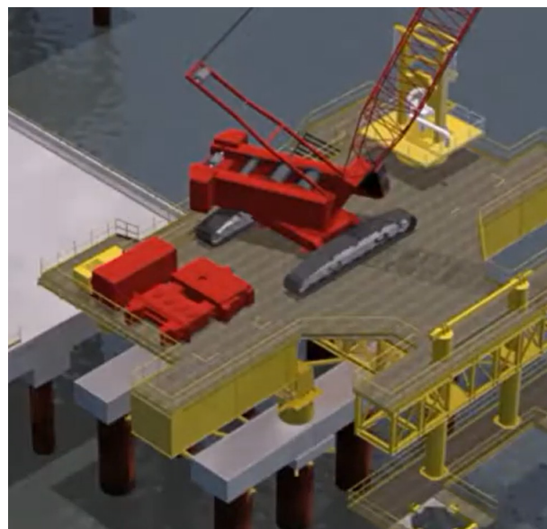
Exemplo de uso do Sistema Cantitraveller - Ponte de Acesso - transporte de estacas.
