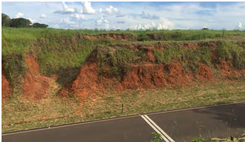
Talude com solo exposto e erosão em curso em via marginal à SP-255
