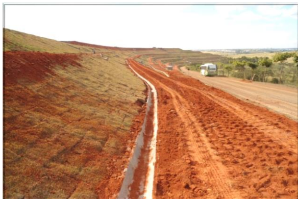
Canaletas de drenagem de águas de taludes.
