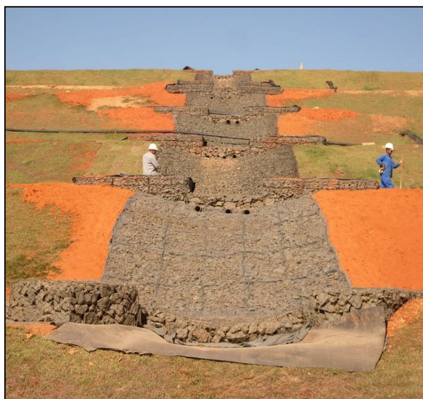
Dispositivos de descidas de água.
