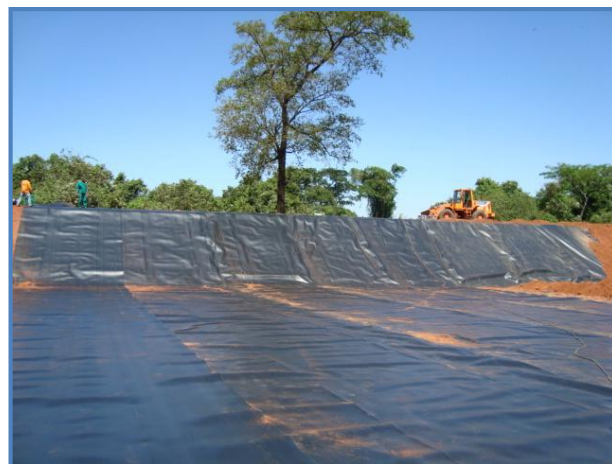
Sistema de impermeabilização de base por meio de geomembrana de PEAD de 2mm.
