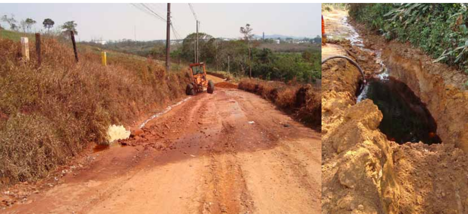
Figuras 4.20 e 4.21 – Local onde ocorreu rompimento de duto e contenção do produto vazado.
