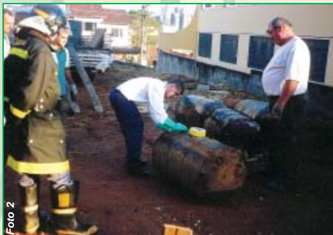
Foto 2 Vedação dos tambores avariados para controle de vazamento durante o carregamento
