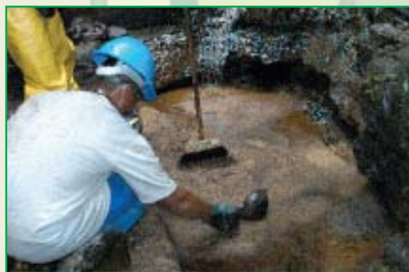
Figura 2 - Aplicação de material absorvente utilizando-se Equipamento de Proteção Individual
