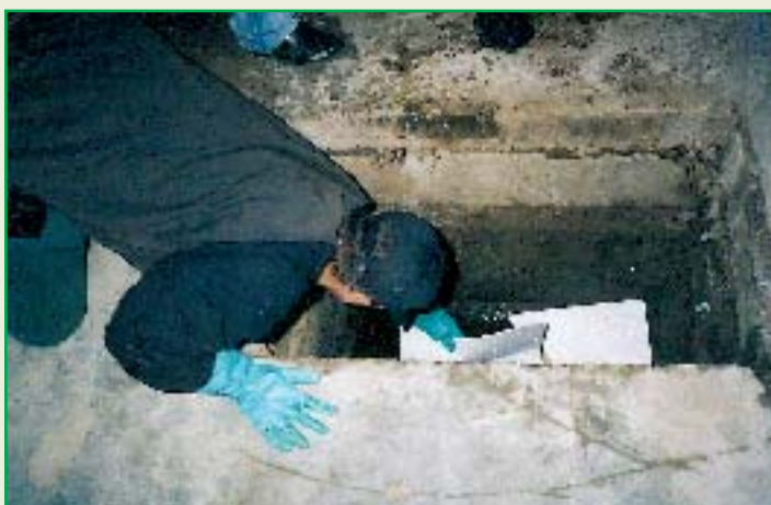
Figura 3 – Aplicação de material absorvente em caixa de passagem de efluentes contaminada por gasolina
