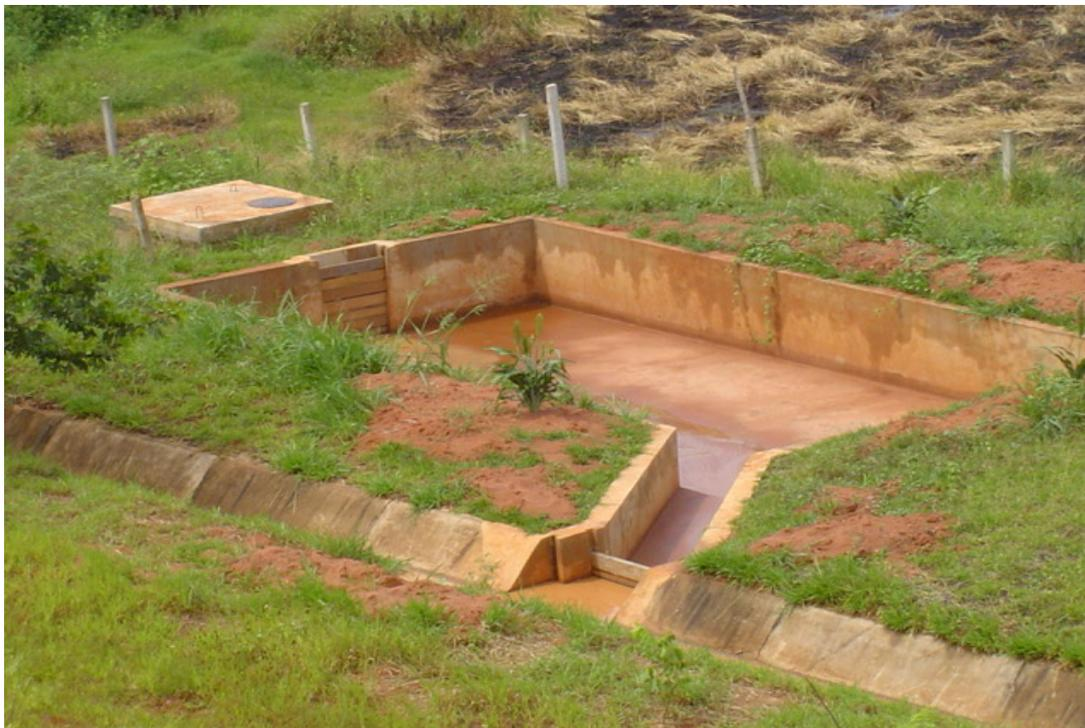
**Figura 5 – Caixa de contenção/retenção para proteção de recurso hídrico em rodovia**
