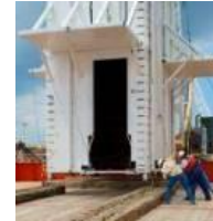
10/maio - 1ª tentativa - cúpula de confinamento
