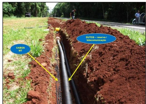
Figura 8 – Enterramento da rede de distribuição – cabos
