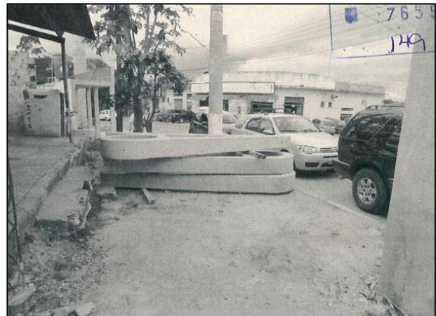
Figura 14 – Armazenamento do material, durante a implantação do empreendimento, impedindo a circulação de pessoas
