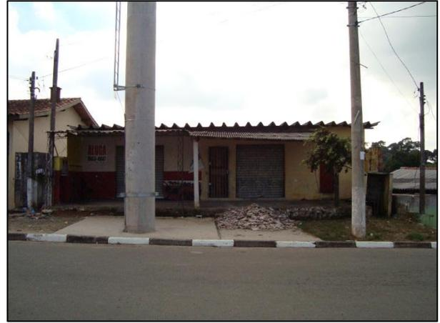
Figura 16 – Poste instalado na calçada onde é possível comparar o porte entre as estruturas de transmissão (à esquerda) e distribuição (à direita) de energia elétrica
