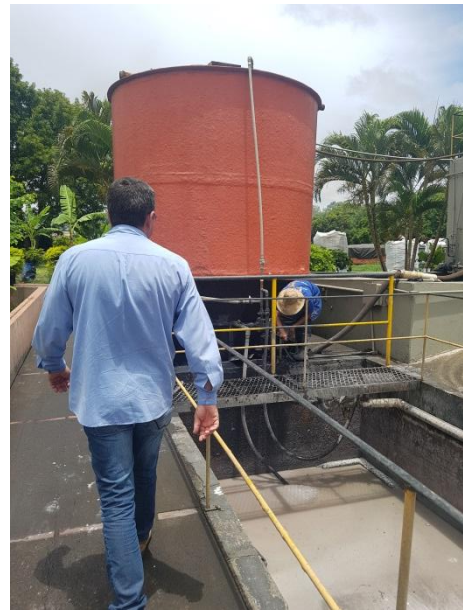
Figura 46 – Resíduo aquoso gerado pós-desidratação do lodo
