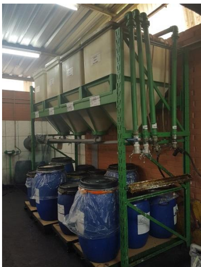
Figura 36 – Tambores onde são realizados os preparos das tintas
