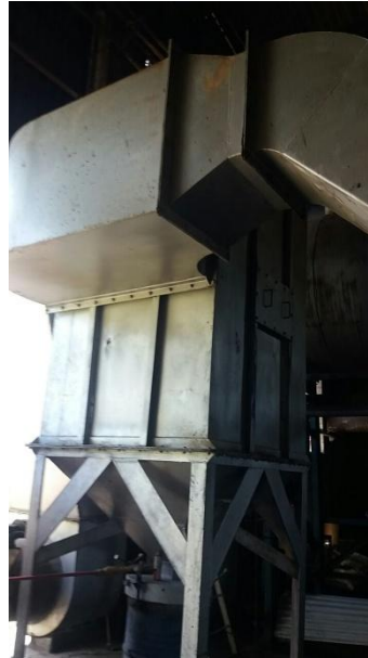
Figura 52 - Filtro Muticiclone vista frontal (Acoplado Caldeira VATI)
