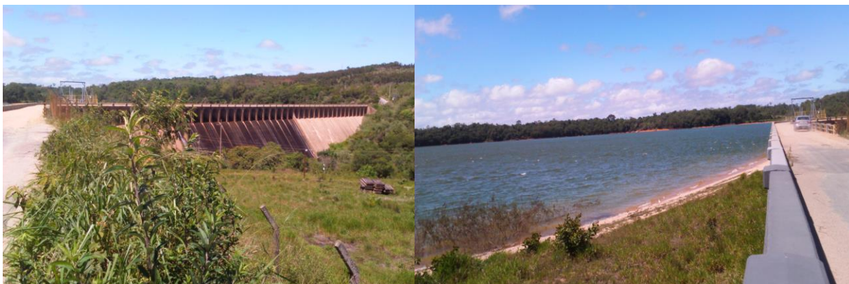
Figura 4 - Fotos da barragem do reservatório Itupararanga
