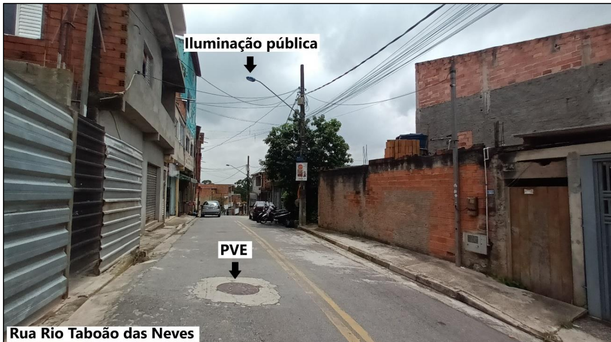
Foto 11 – Infraestrutura da Rua Rio Taboão das Neves.
