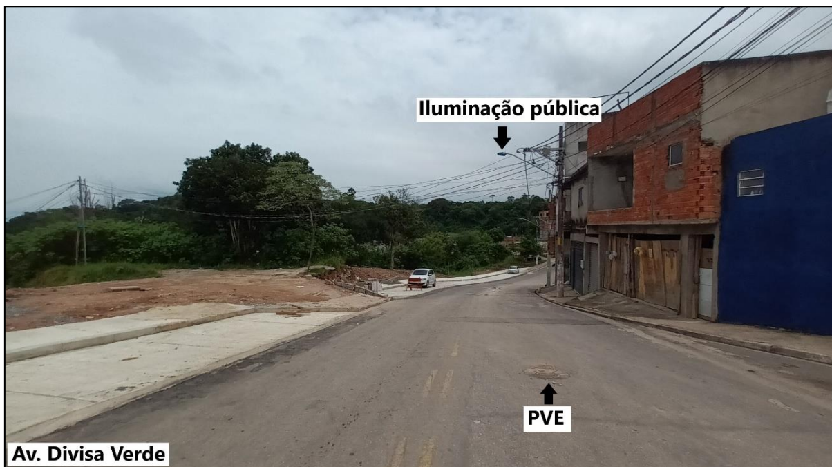
Foto 13 – Infraestrutura da Av. Divisa Verde.
