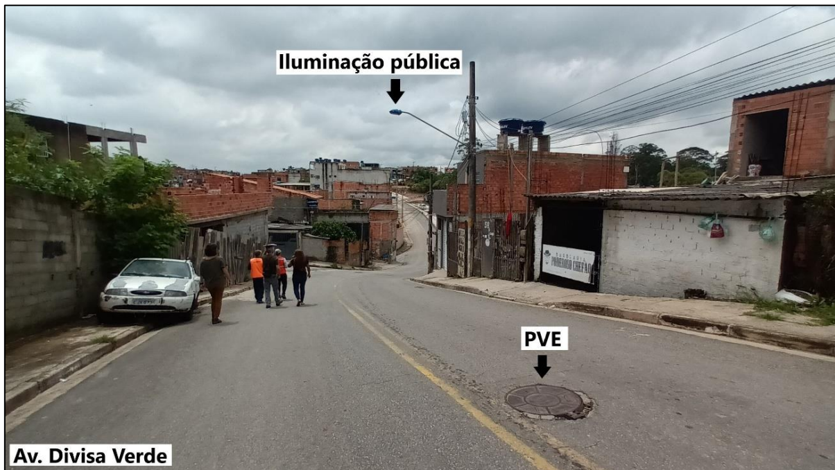
Foto 10 – Infraestrutura da Av. Divisa Verde.
