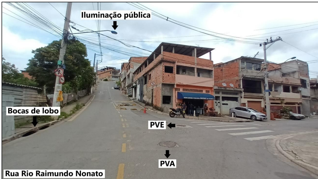
Foto 16 – Infraestrutura da Rua Rio Raimundo Nonato.
