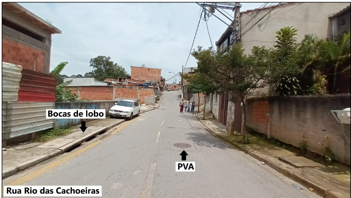
Foto 14 – Infraestrutura da Rua Rio das Cachoeiras.
