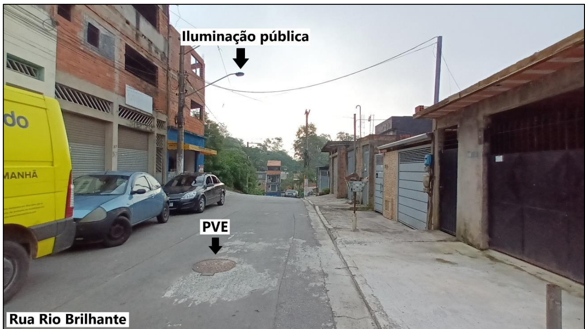
Foto 7 – Infraestrutura da Rua Rio Brilhante.
