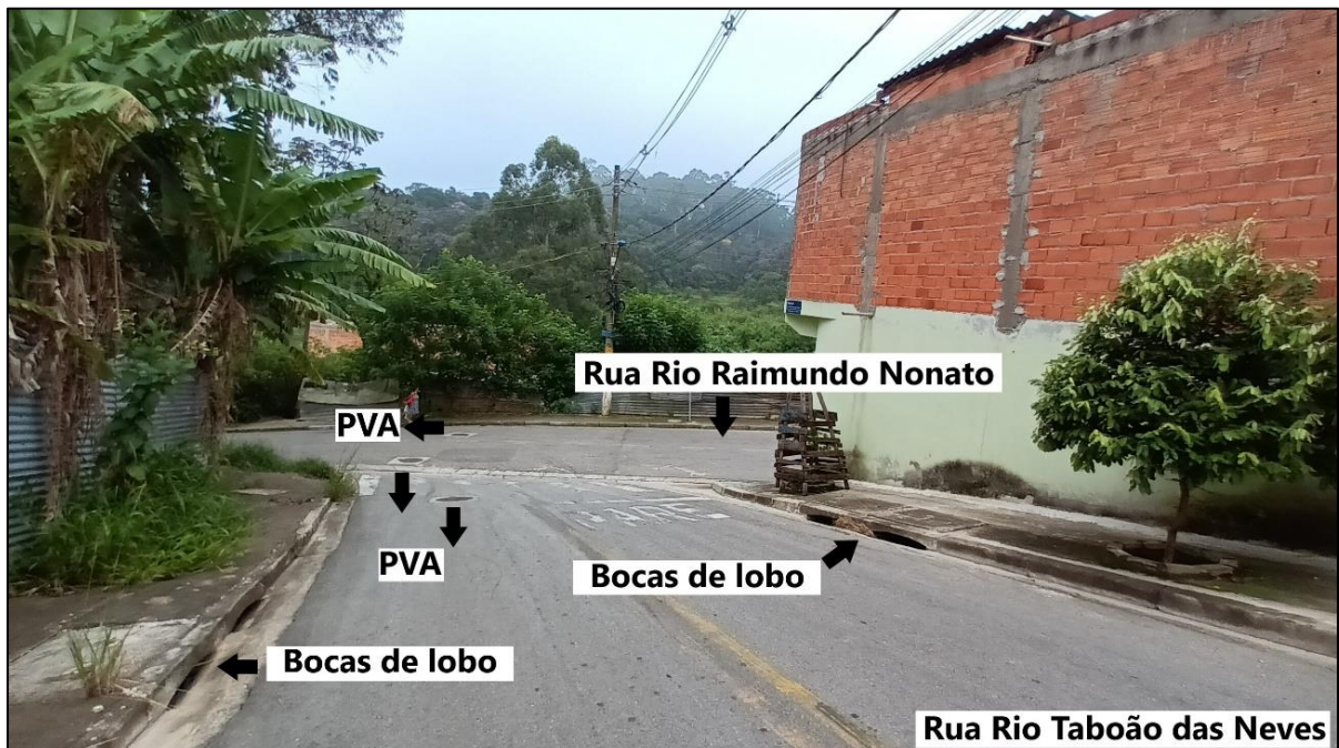
Foto 17 – Infraestrutura da Rua Rio Taboão das Neves com Rua Rio Raimundo Nonato.
