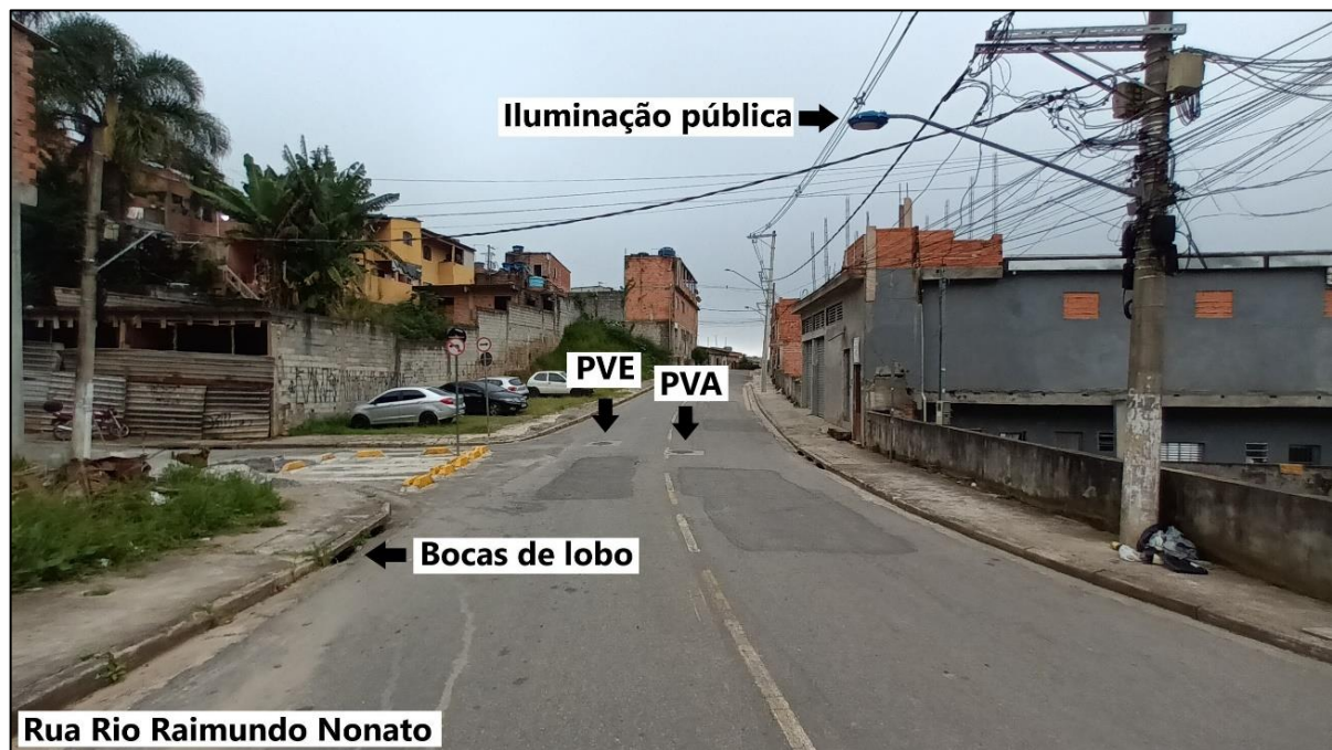
Foto 15 – Infraestrutura da Rua Rio Raimundo Nonato.
