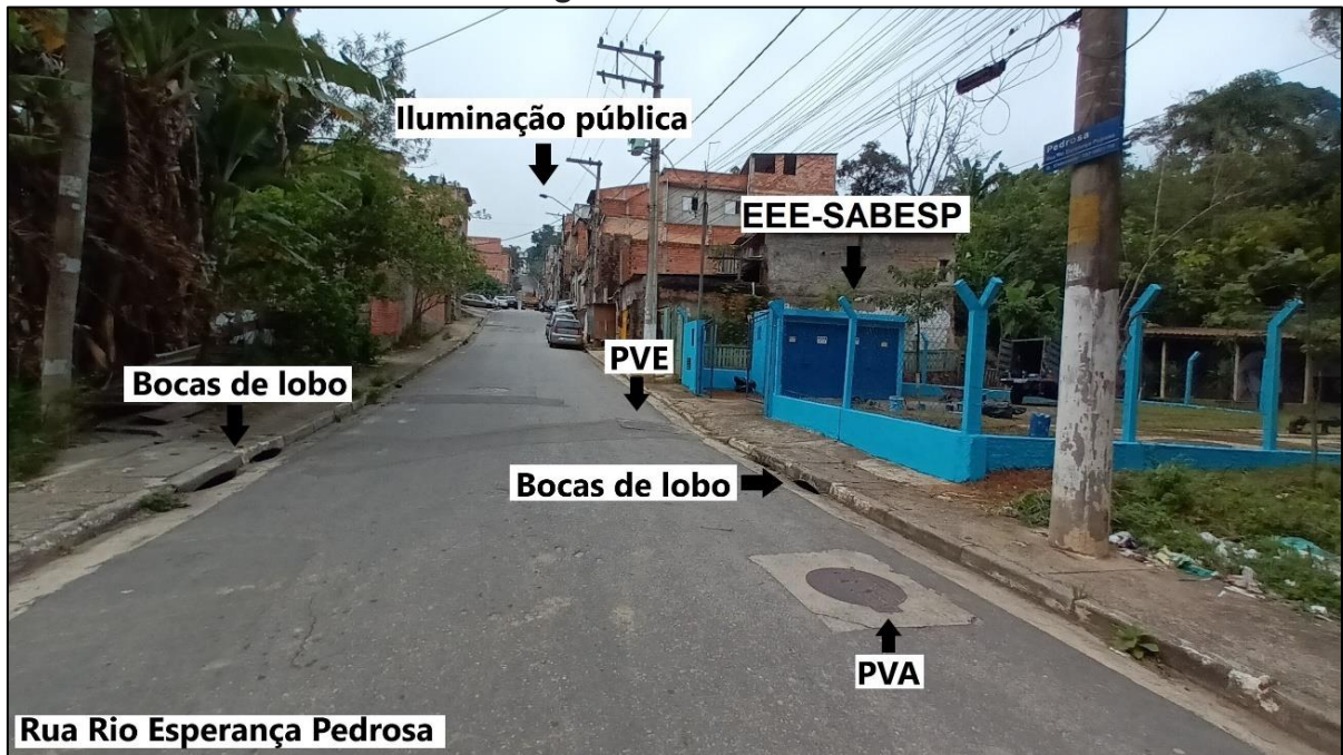
Foto 4 – Infraestrutura da Rua Rio Esperança Pedrosa. Estação Elevatória de Esgoto da SABESP.
