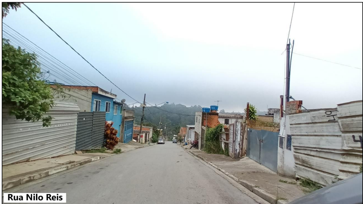
Foto 6 – Infraestrutura da Rua Nilo Reis.
