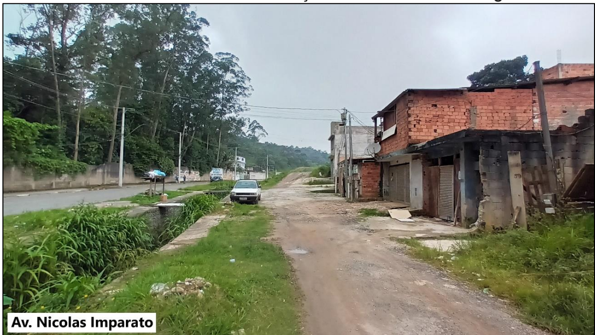
Foto 1 – Moradias na Área de Preservação Permanente do Córrego da Olaria.
