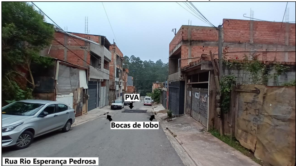
Foto 5 – Infraestrutura da Rua Rio Esperança Pedrosa.
