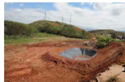
O aterro em fase de adequação.
