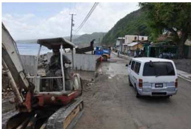
Trabalhadores constroem um muro de contenção na costa sul de Dominica.
