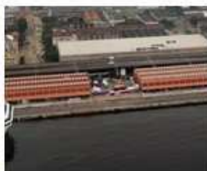
F) Pier Mauá e Galpão da Cidadania
