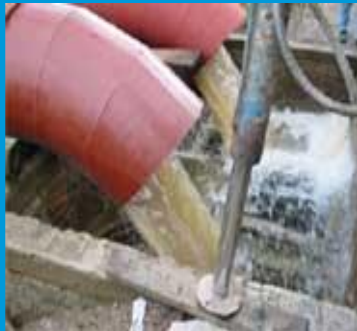
BOMBA DE ESGOTO PLUVIAL
