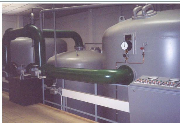
b) Interior da instalação, com a tubulação do poço, sistema de medição de vazão e sistemas de tratamento para remoção de ferro.
