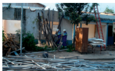
Separação de materiais durante demolição.
