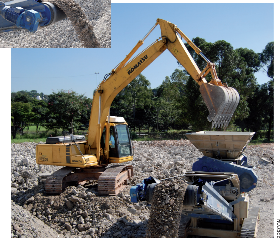
Britagem no canteiro de obras
