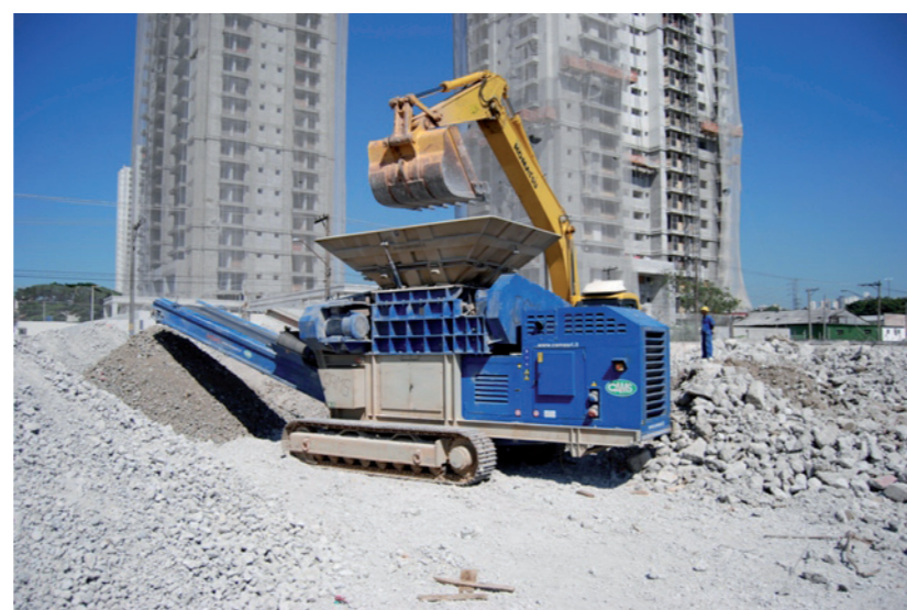
Britagem para reciclagem de Resíduos Classe A no próprio canteiro.
