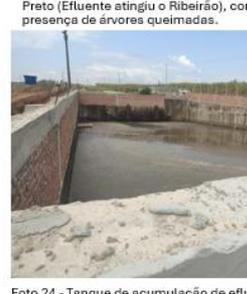
Foto 24 - Tanque de acumulação de efluentes, observa-se mancha nas paredes indicando nível mais elevado de efluentes que passou por ele.
